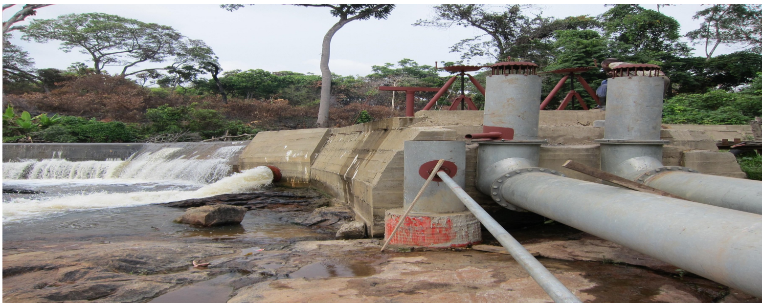
Project Elkap Congo - aangebracht door SOFIA
