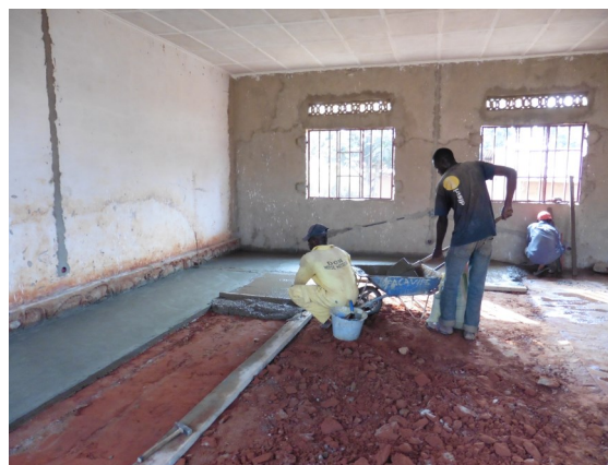
PR17/020 Renovatie van klaslokaal
